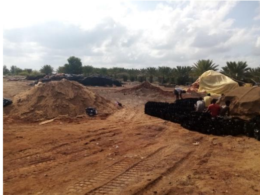
Photo 3 : Préparation des terres végétales
