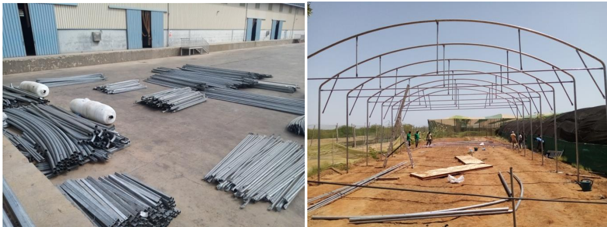
Photo 12 et 13 : Assemblage des matériels et équipement de tunnel
